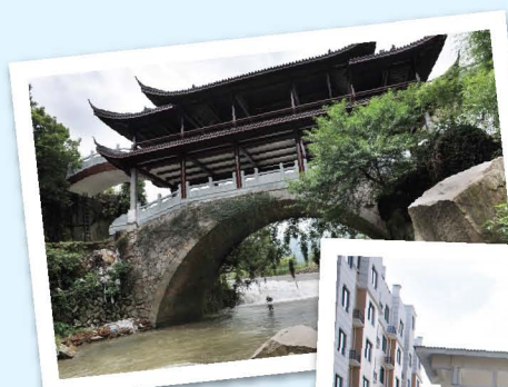
宁波结对帮扶建设的云和栈云桥
